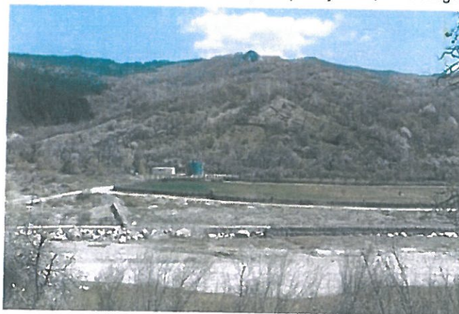
Apărări de mal pe partea stângă a râului Ialomița
